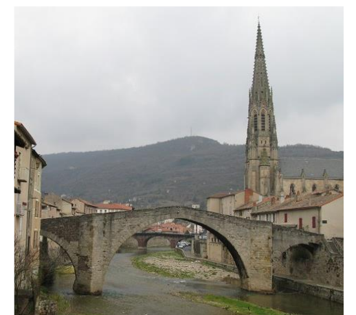
⑪ Pont de Saint-Affrique Franchissant la Sorgue, ce pont fut construit vers 1270.
