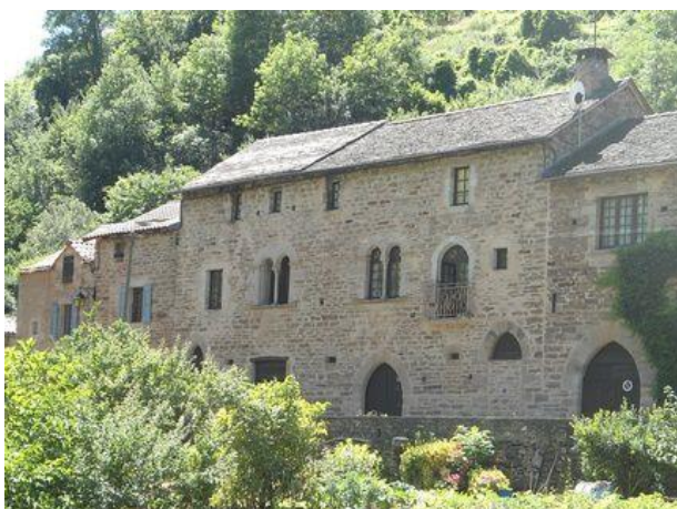
⑦ Maison à Viala-du-Tarn Située à l'entrée du village du Minier, dans une vallée rejoignant le Tarn, elle témoigne de la richesse du village qui s'est développé au XIIe siècle avec la découverte des mines d'argent.
